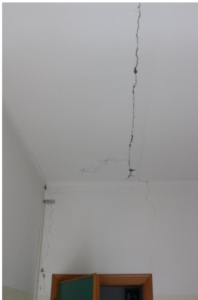
Figura 25- Danneggiamento solaio e muratura
