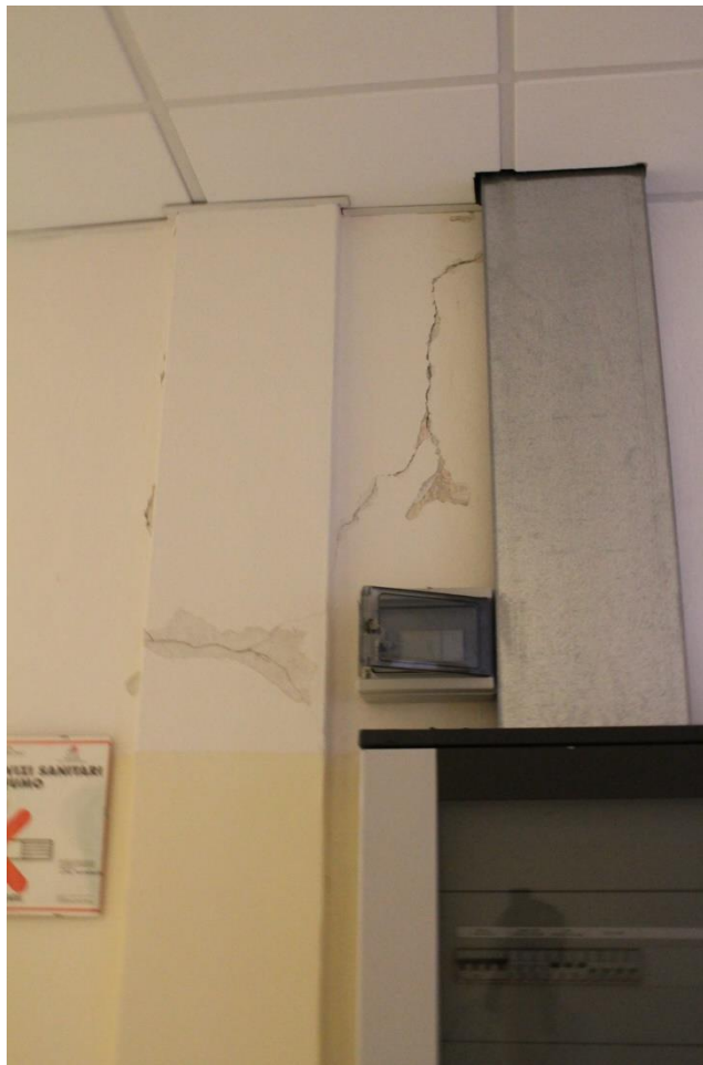
Figura 17- Espulsione paramento murario
