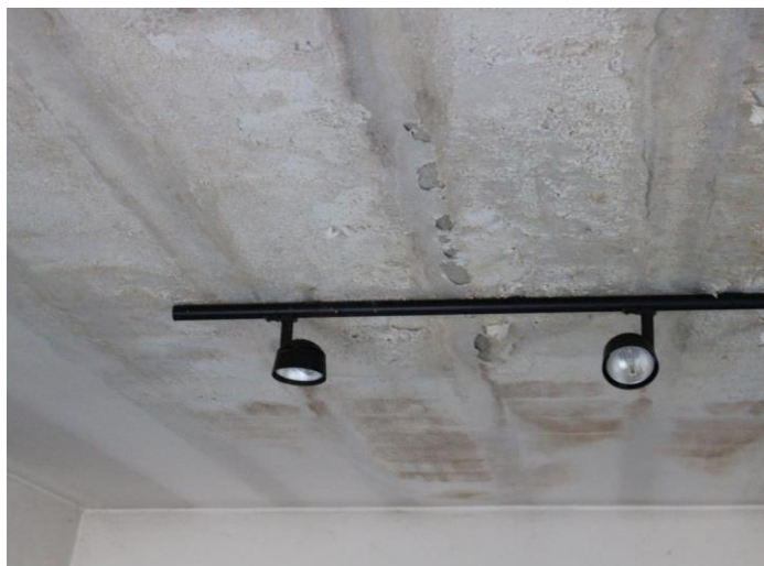
Figura 26- Infiltrazioni di acqua dalla copertura
