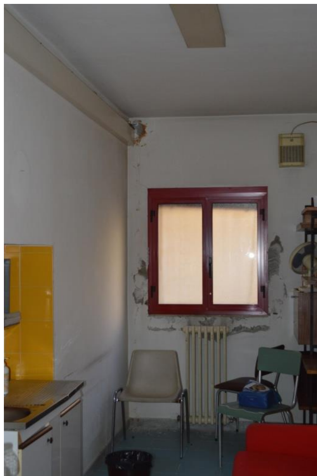
Figura 14- Distacco intonaco in cucina
