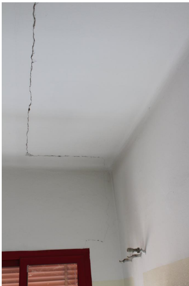
Figura 24- Danneggiamento solaio e muratura
