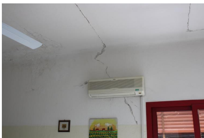
Figura 22- Danneggiamento solaio e muratura
