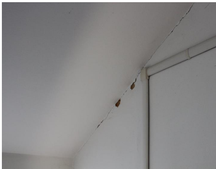
Figura 28- Distacco tra solaio di copertura e muratura
