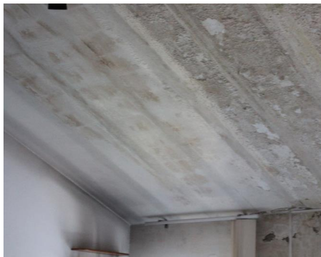
Figura 27- Infiltrazioni di acqua dalla copertura
