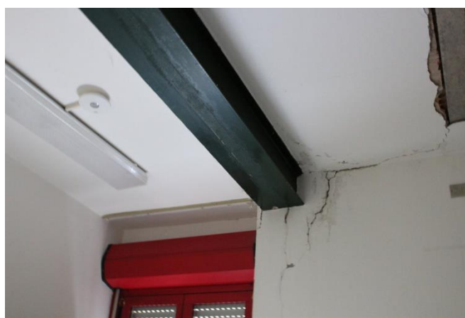
Figura 23- Danneggiamento solaio e muratura
