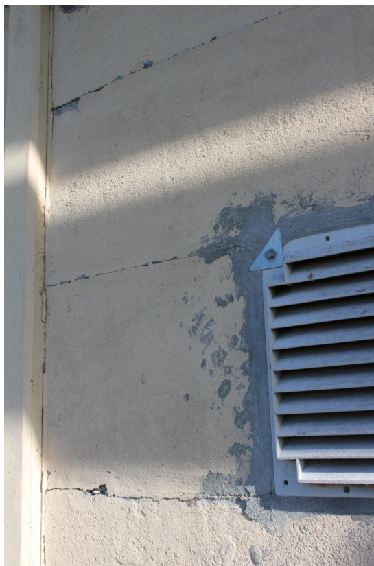
Figura 30 e Figura 31- Lesioni in corrispondenza dei pilastri e dei tamponamenti
