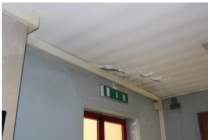
Figura 20- Danneggiamento solaio e muratura
