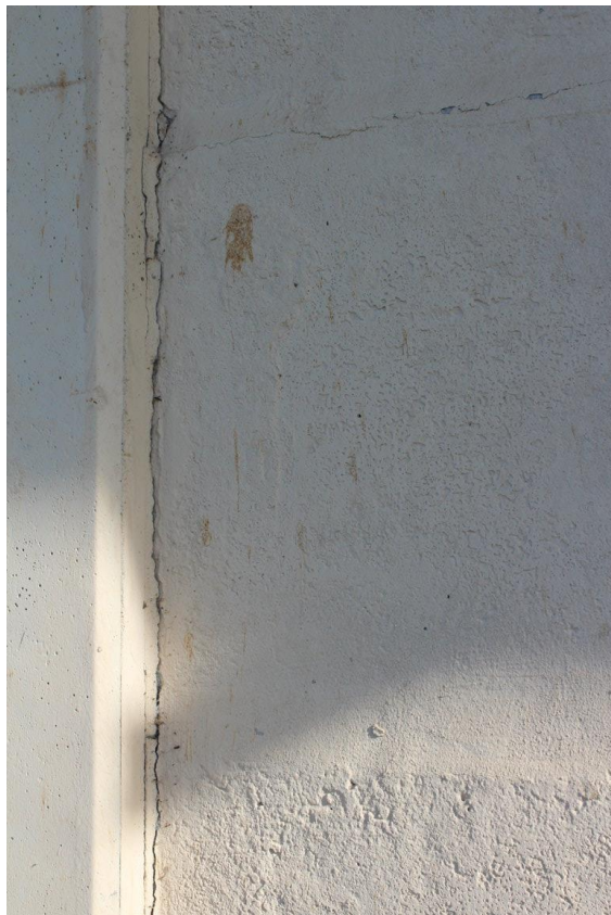
Figura 30 e Figura 31- Lesioni in corrispondenza dei pilastri e dei tamponamenti
