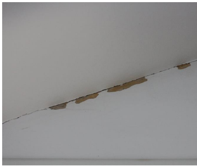
Figura 29- Distacco tra solaio di copertura e muratura
