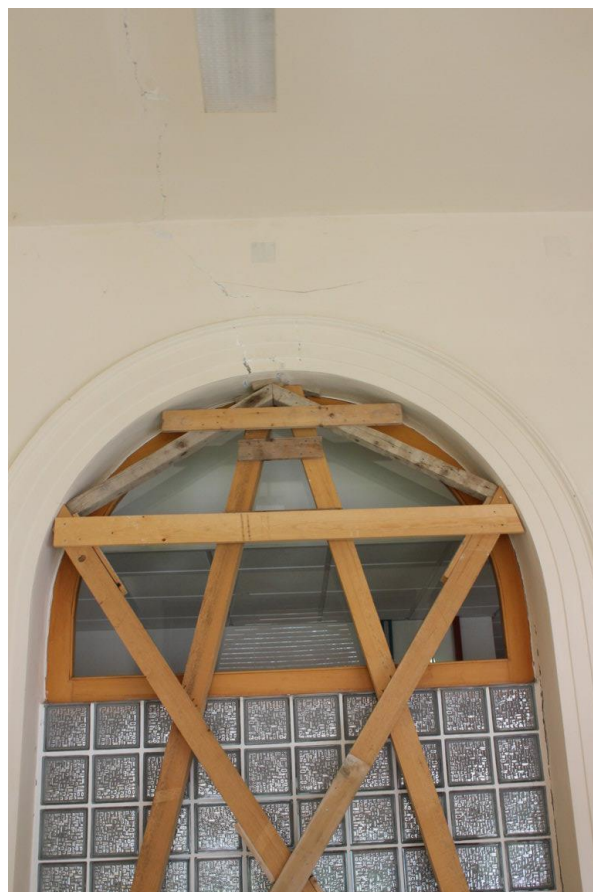
Figura 19- Danneggiamento solaio e muratura
