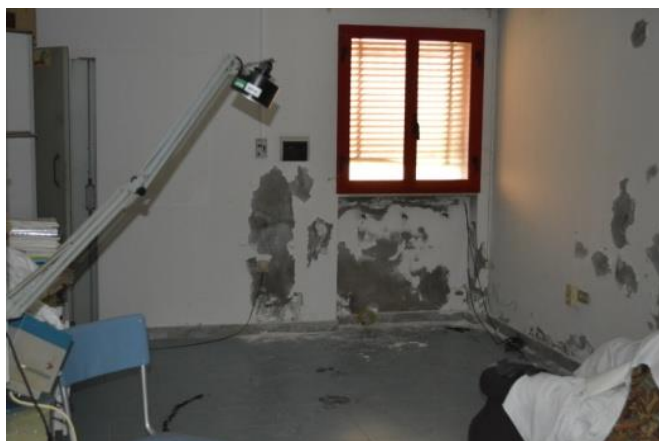
Figura 13- Distacco intonaco dello studio
