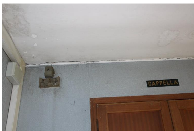
Figura 21- Danneggiamento muratura
