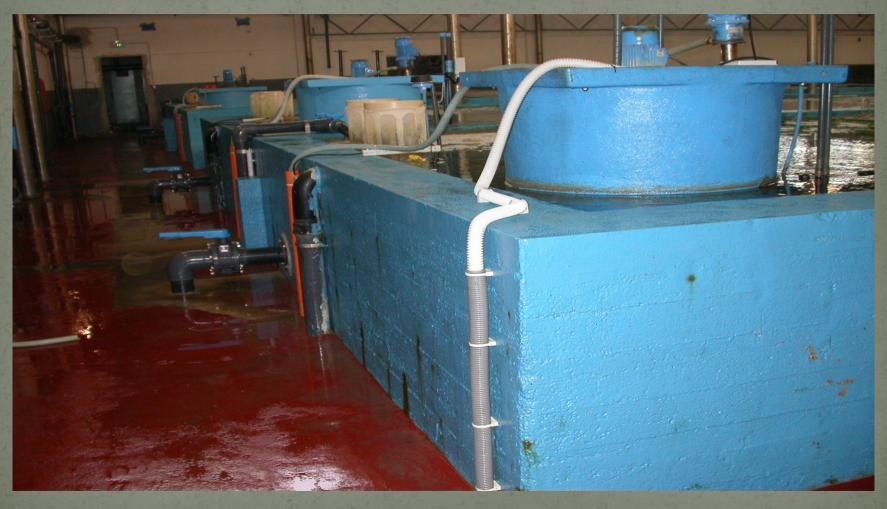
L'impianto a circuito semichiuso prevede che l'acqua venga rimessa in circolo con apposite tubazioni e pompe dopo aver subito un trattamento di raffreddamento o riscaldamento e di ulteriore clorazione
